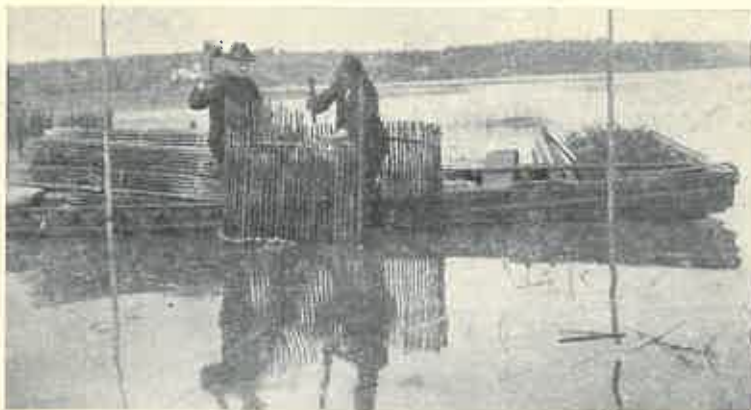
Bild 76. Fiskaren Walter Blomqvist, Borgå, med hjälpkarl har satt ut det ena »bostycket» uti det ena av katsens båda »bon» och klubbar nu ned spjälken i botten för att fixera dess läge. Kinkigt arbete, ty boet skall »ställas» rätt för att katsan skall fiska bra.
