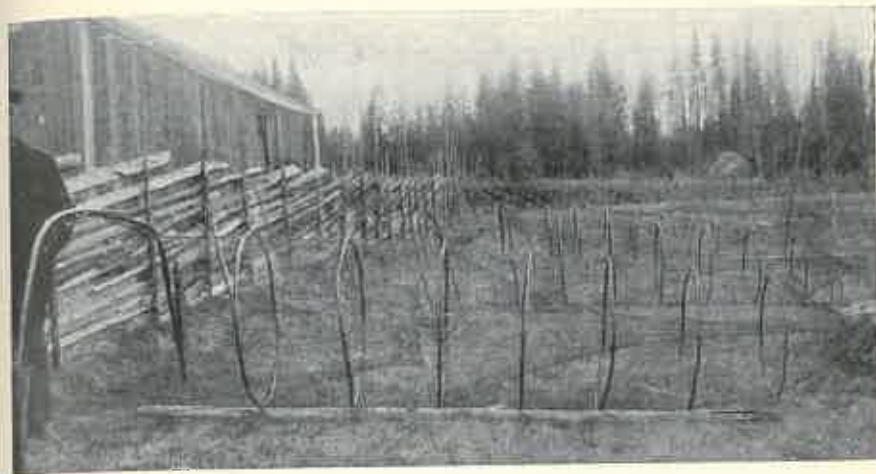
Bild 66. Gäddryssjor av prima typ, bundna och monterade år 1923 av fiskarveteranen Oscar Hansson på Björnvik (Strömfors, östra Nyland). Obs! glest bundna ryssjor, långa ingångar med jämn sluttning och smäckra gjordar samt väl konserverade med stenkolstjära.
