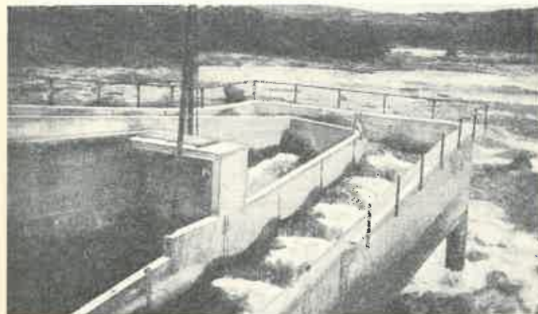
Bild 44. Fisktrappan vid Norrforsen i funkt.on. Nivådifferens mellan närliggande kamrar 20 cm. (Ur »Nordens Fiskar och Fiske»).
