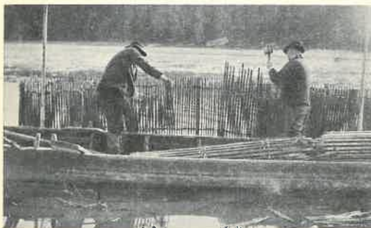
Bild 77. De båda »boen» redan på sin plats, likaså »gavelstycket». De korta »getingarna» placeras nu och därefter »gärden» med den ena ändan mitt i den vida öppningen mellan getingarna och med den andra gårdstyckets borte ända vid följande »kats huvuds» ryggpåle.
