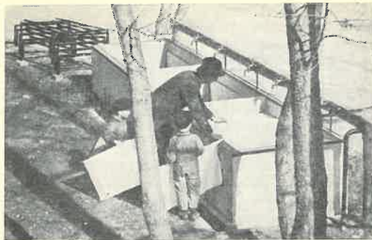
Bild 31. Reservbassänger utomhus för kläckning av gäddyngel vid Ostuna fiskodlingsanstalt. Tygstycken för gäddlarvarnas anfästning hängas på sin plats av anstaltens föreståndare. Vattentillförsel underifrån genom talrika små hål i väggarna på rör nära bassängens botten. Både vanligt jiltrerat ävatten och varmvatten kan ledas in i bassängerna t. h. på bilden. C. Segerstråle foto.
