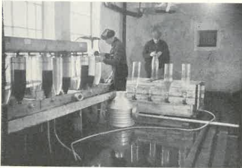
Interiörbild från den i november 1939 under uppförande varande kläckningsanstalten i Nykarleby Kraftverk. Till vänster 16 sikglas i låga plätställ av Vuohensalo-typ. Sikglasen (av den nya svenska typen rymmande 8 liter) äro tillverkade på Karhula glasbruk i Finland. Mitt på golvet en transportkanna för fiskyngel. Avdelningen till höger ännu ej färdig.
