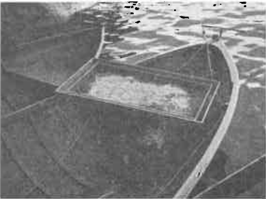
Kuva 41. Näsijärvelläsiimassa pitkäsiimalaatikossa on keskimäärin 350 koukua 10 metrin välimatkoille laitettuina. Siimalaatioissa on erillinen ulospäin kallistuva ulkoreuna, joka estää syöttien sekaantumista siimoja nopeakulkuisista moottoriveneistä laskettaessa. Valok. S. Ahlgrén 1955.
